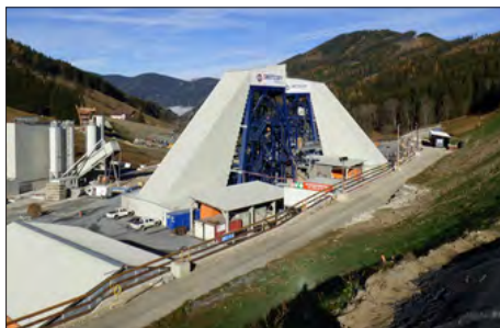
Fig. 2: Shaft sinking machinery for Semmering Base Tunnel at Fröschnitzgraben [Foto: SWIETELSKY]
