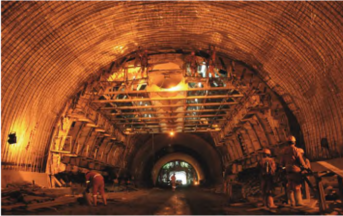
La Línea Tunnel. Taken from National Highway Institute (INVIAS) - ( http://www.reporterosasociados.com.co )
