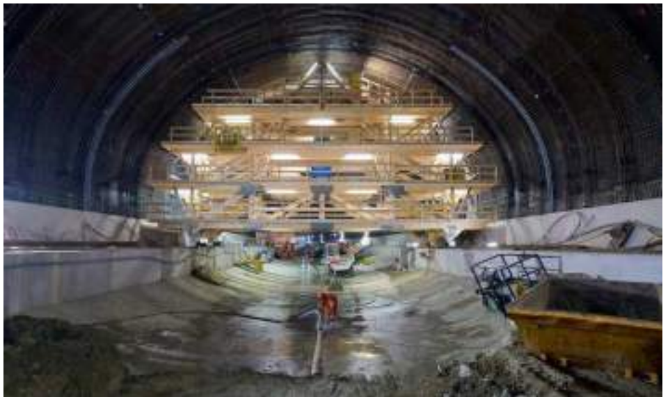
New RBS underground station (Bern)
