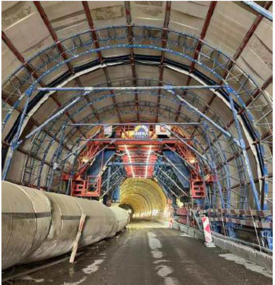
Evouettes road tunnel (Wallis)_
