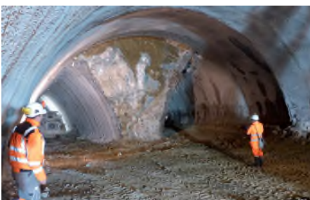
STS Fall Excursion 2016, 09.11.2016 Galgenbuck Tunnel, Schaffhausen
