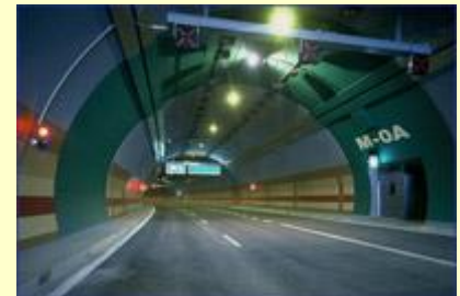
Mrázovka tunnels, Prague City Circle
