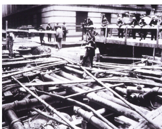
Une photographie, datant de 1918, illustre l'enchevêtrement des réseaux souterrains sous Wall Street, à New York
